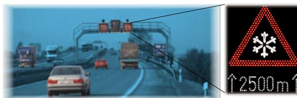
Abb.3 VMS – Variable Message Signs entlang von Autobahnen
